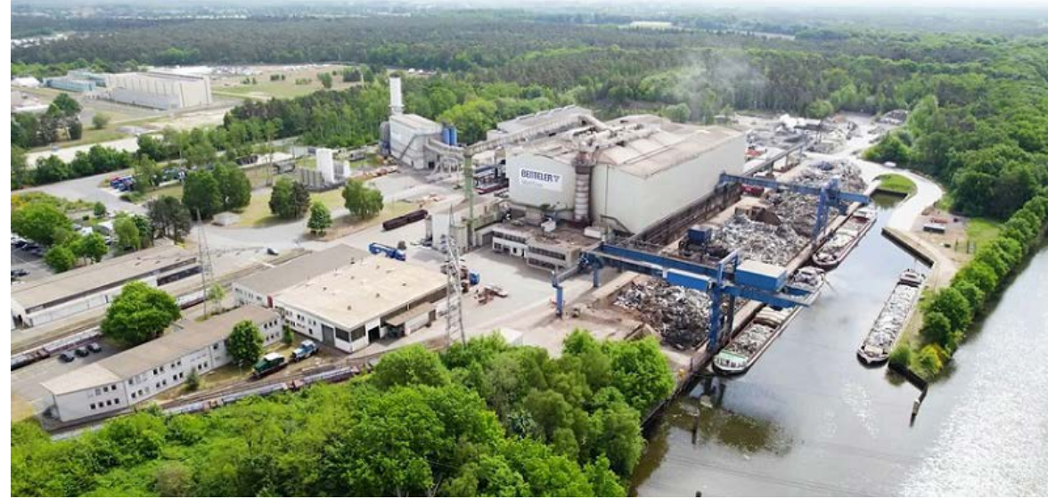
In unserem Stahlwerk in Lingen produzieren wir seit fast 50 Jahren umweltfreundlichen Stahl mit einem Elektrolichtbogenofen
